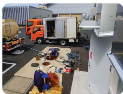
地下式タンク清掃
