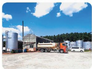
廃油再生工場
