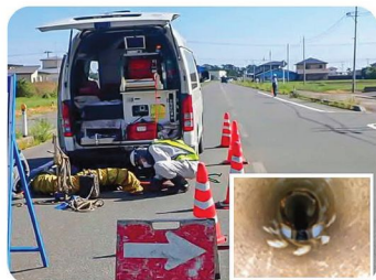
下水道管路の調査・診断
