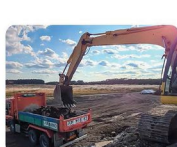
土砂や碎石などを運ぶ10tダンプ車
