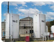
油水分離施設 （鉱物油の油水分離）
