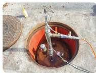
漏洩・耐圧検査
