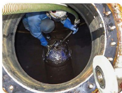
地下式タンク清掃
