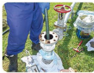
ボイラー配管洗浄
