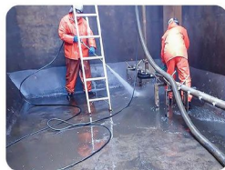
汚水桝の清掃
